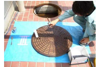
④下塗り 攪拌後のシグマ01を塗布。
