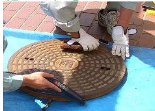
①養生・清掃(乾式) サビ、汚れ等の除去。
