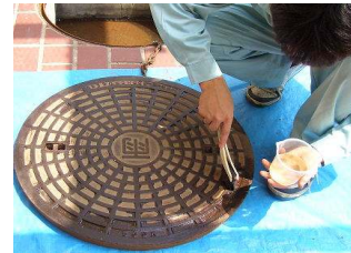
③プライマー塗布 専用プライマー塗布。
