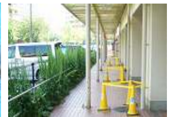
⑧完了・乾燥 乾燥24時間。 80°C以下で強制乾燥可能。
