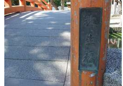
⑩マスキングライン撤去、完了
