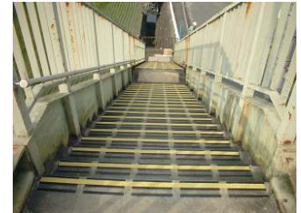
大阪府 歩道橋段鼻
