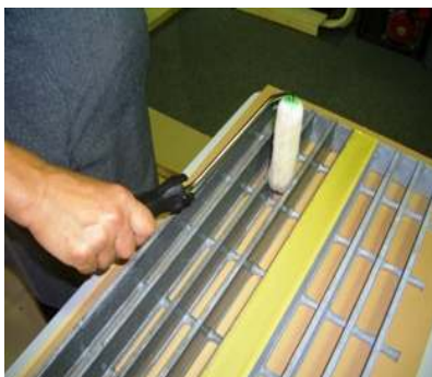
③専用プライマー塗布
