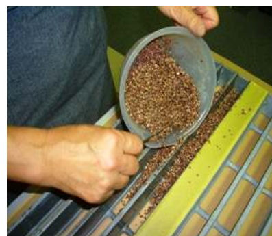
⑤Σ03と骨材を混合したものをヘラ等を用いて入れる
