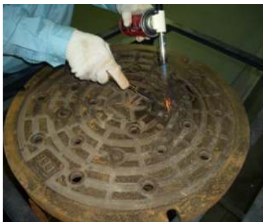
①アスファルト等の除去
