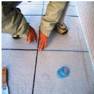
②目地棒 マスキングテープ貼り
