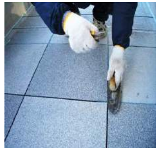
⑦塗り込み中にマスキングテープめくり
