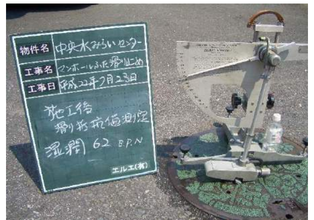
湿潤時施工後マンホール蓋・B.P.N 62
