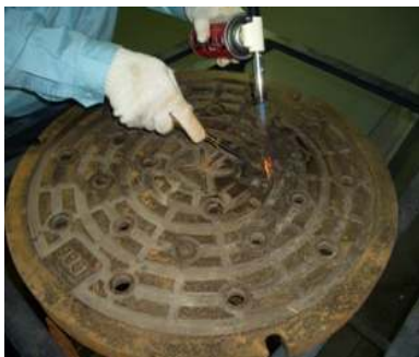
①アスファルト等の除去
